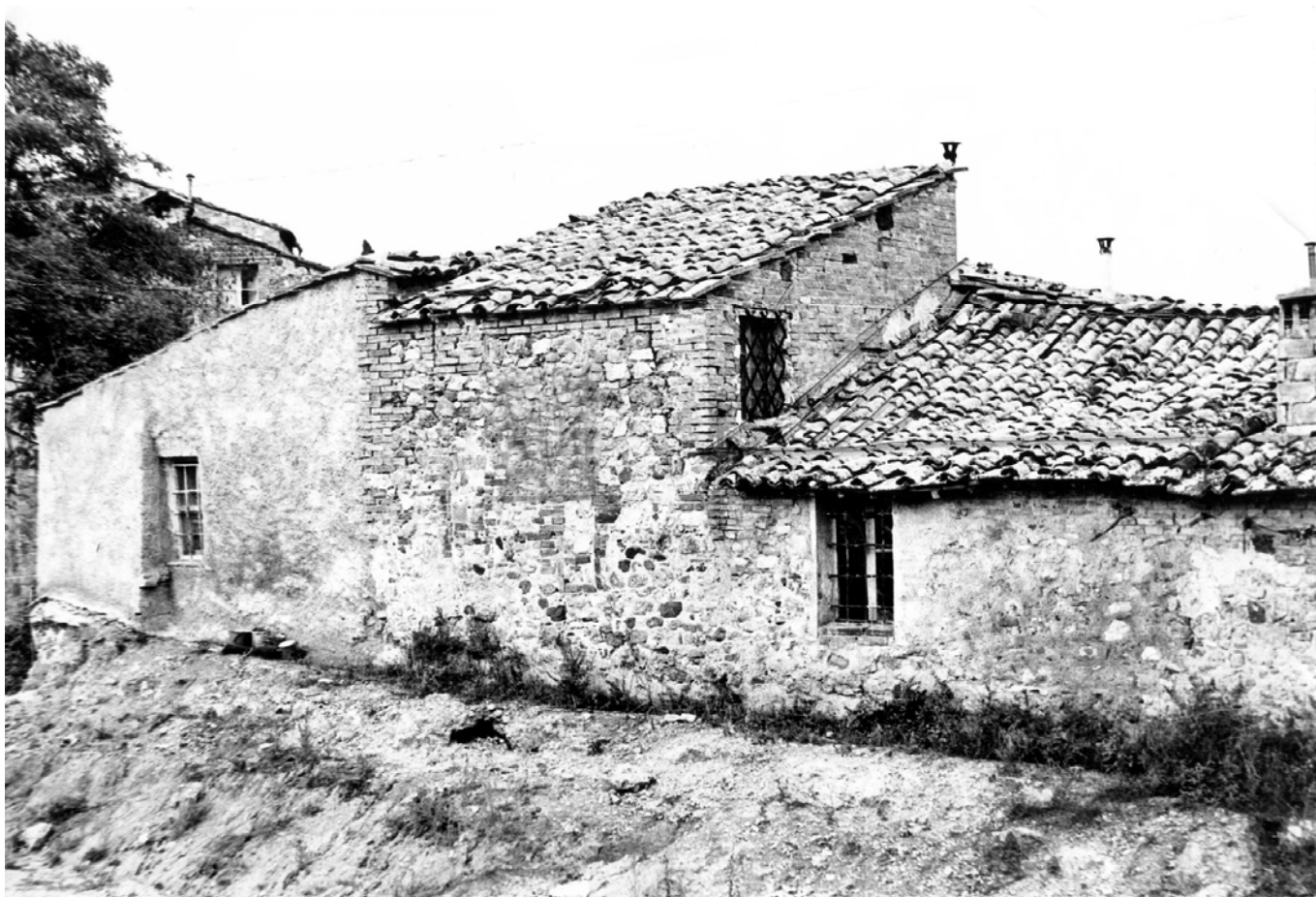
Fig. 5 Retro del fabbricato che era anticamente proprietà dell'ospedale, in una foto dei primi anni '70.
