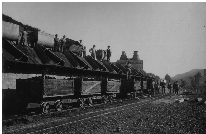
Fig. 1. Il piano caricatore alle Miniere di Murlo in piena attività negli anni 1918-1920, quando la copertura e la fornace Hoffman non erano ancora stati costruiti; a destra si intravedono i camini della fornace detta “La Fortezza”, non ancora modificati dalla SAI-ANSALDO (foto gentilmente concesse da Rosalba Orlandi Gbilardi).
