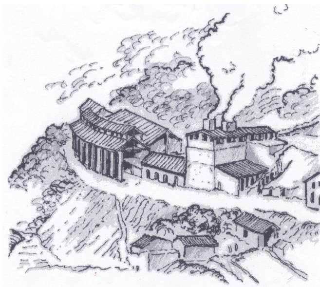
Fig. 4. Ricostruzione di un particolare dal disegno di Dario Neri di fig. 1. Si vedono i pilastri e la copertura del piano caricatore e il resto della copertura della fornace Hoffman per laterizi. Subito a destra, con i camini fumanti, la fornace di calce oggi conosciuta come "la Fortezza" (disegno di L. Scali).
