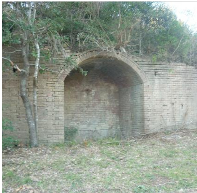
Fig. 3. Nella foto a sinistra in alto, la strada di Miniere di Murlo con le tracce dei basamenti in pietra sui quali poggiavano i pilastri della copertura del piano caricatore; sotto, un particolare del muro di contenimento con la nicchia di ricovero. Nel disegno, una ricostruzione delle strutture ancora oggi visibili: il muro del piano caricatore, i basamenti dei pilastri, e le due piccole fornaci di calce aerea (foto e disegno di L. Scali).
