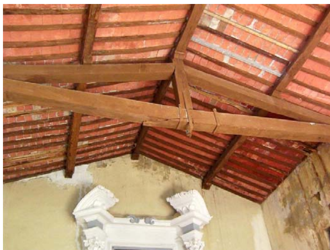
Fig. 1 Il sottotetto della chiesa dei SS. Pietro e Paolo a Montepescini.
