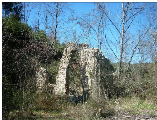
Facciata locale argani- aprile 2010
