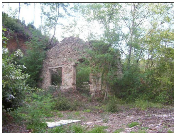
Facciata locale argano- settembre 2007
