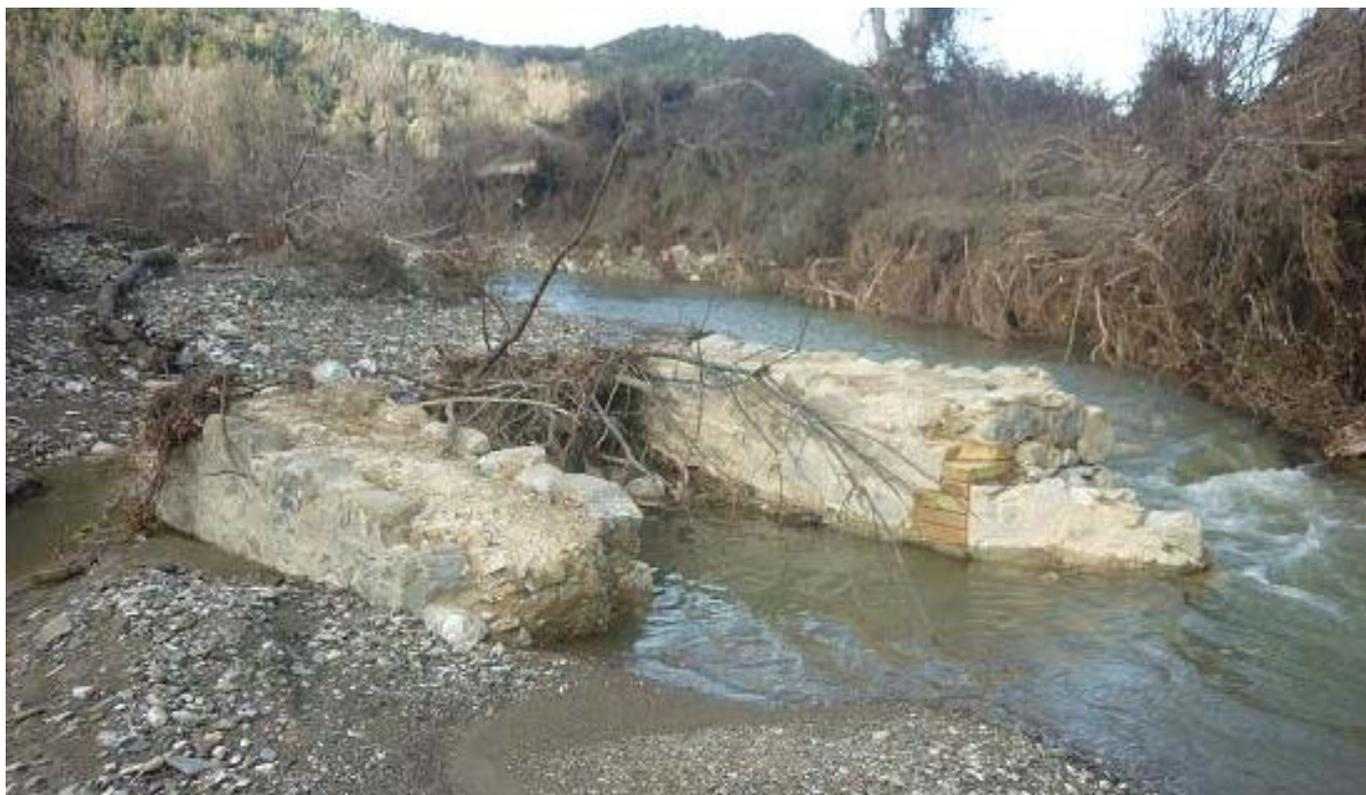
Fig. 2. I due pilastris del ponte di Peratti sul torrente Crevole, portati alla luce dalle piene di ottobre 2013.
