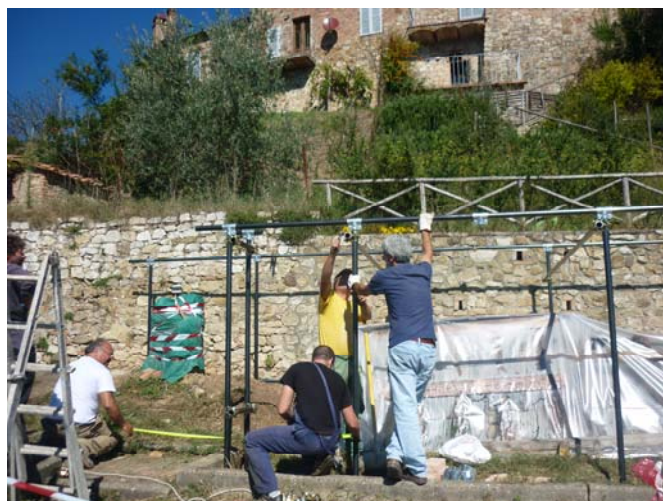
Volontari all'opera per la nuova copertura, dopo la protezione del forno verticale e della fossa di fusione.
