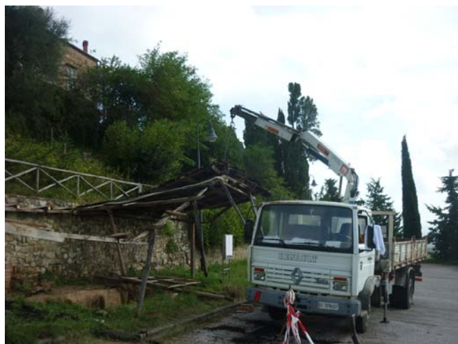
Il sollevamento e l'asportazione della vecchia copertura, grazie al lavoro manuale e ai mezzi messi a disposizione dai cittadini.
