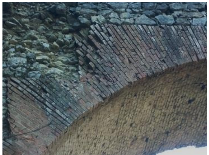
Fig. 2. La stupenda tecnica usata sull’arco del fornice sul torrente Crevolone per far correre in piano il paramento esterno atto a contenere il riempimento del ponte stesso.
