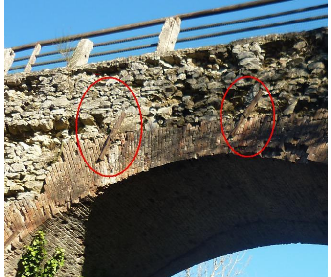
Fig. 1. Particolare del fornice stradale del ponte sul torrente Crevolone, con evidenziate le chiavi delle catene di consolidamento della struttura, realizzate con spezzoni di binari "Vignoles".
