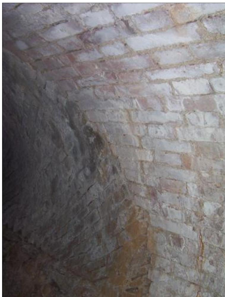
Fig. 1. Il tombino del Serpentaio. In alto l'arco a ventaglio della porta di uscita, in basso il punto di giunzione fra le due volte.
