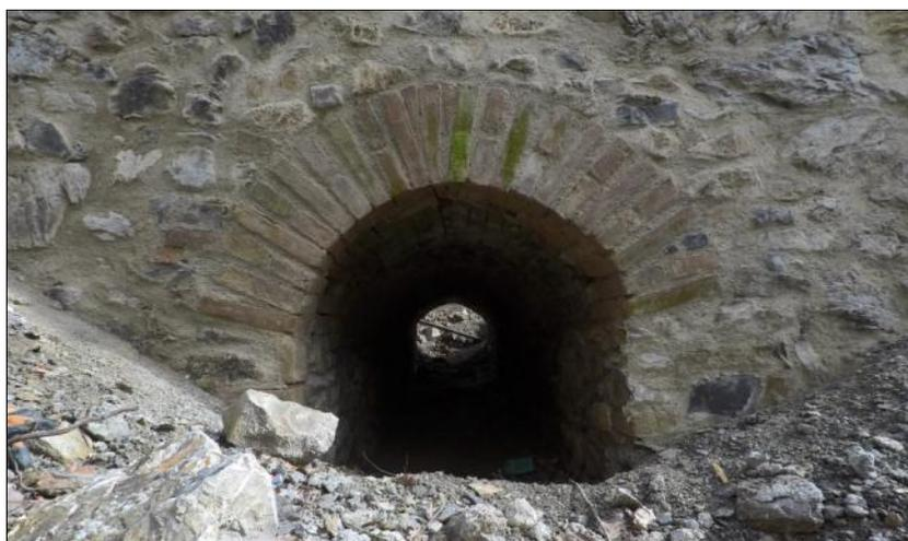
Il passaggio per il goretto del Mulino dei Frati riportato alla luce con i lavori sul paramento del ponte. Il goretto portava l'acqua del Crevolone, intercettata poco a monte con un'opera di sbarramento in muratura, fino al Mulino, che era evidentemente ancora in attività quando fu costruito il ponte.
