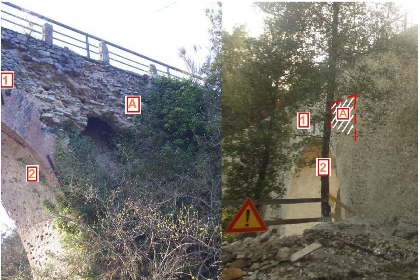
Interventi sulle lesioni del ponte: A - riempimento interno e ricostituzione del paramento; 1 - consolidamento dell'arco; 2 - consolidamento dell'intradosso.
