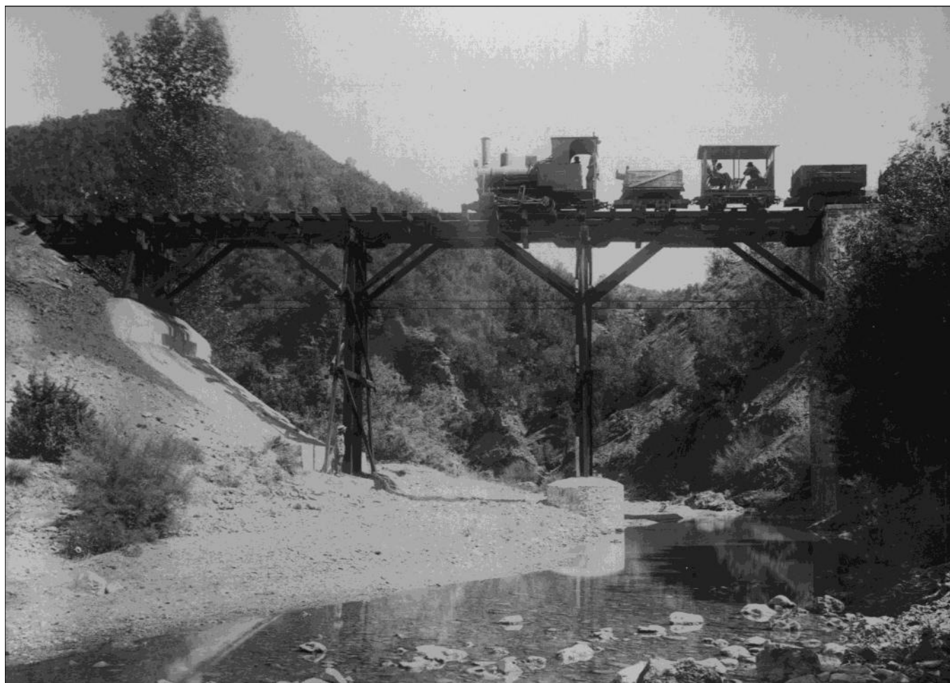
Il Ponte Nero in una foto del 1919, quando ancora aveva la struttura in legno. Il trattamento conservativo con carbolineum dei materiali in legno conferì il caratteristico colore nero alla struttura (immagine dall'archivio di Rosalba Ghilardi gentilmente concessa all'Associazione Culturale).
