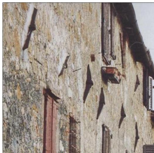
Fig. 1. Nella foto sopra, l'edificio di Vallerano con la sequenza di catene inserite sulle travi. A sinistra, ricostruzione della struttura (con A e B sono indicate le chiavi terminali della trave-catena).
