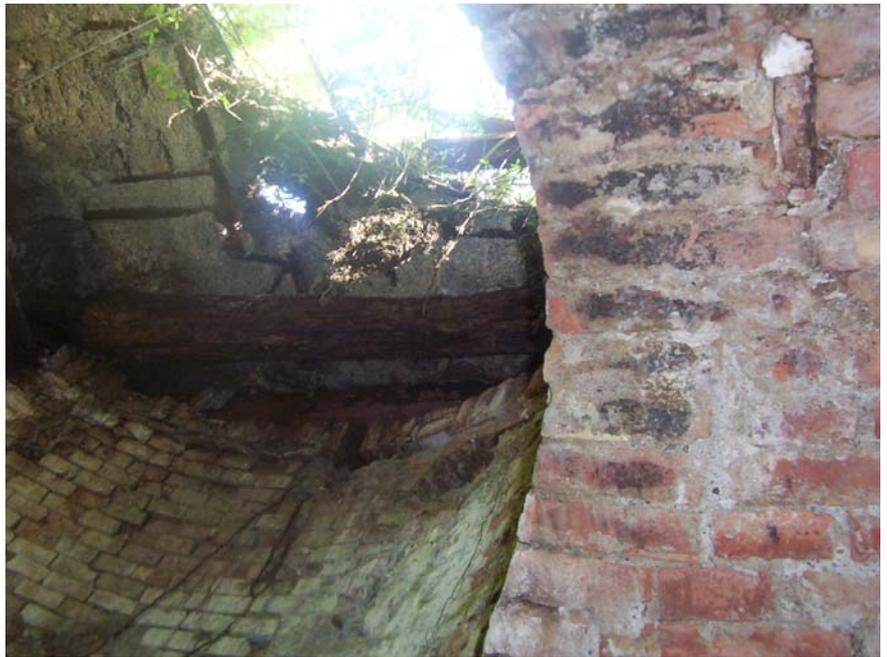
Fig. 4 Armatura del cemento armato del pozzo del Cerrone, realizzate con le testiere del letto.
